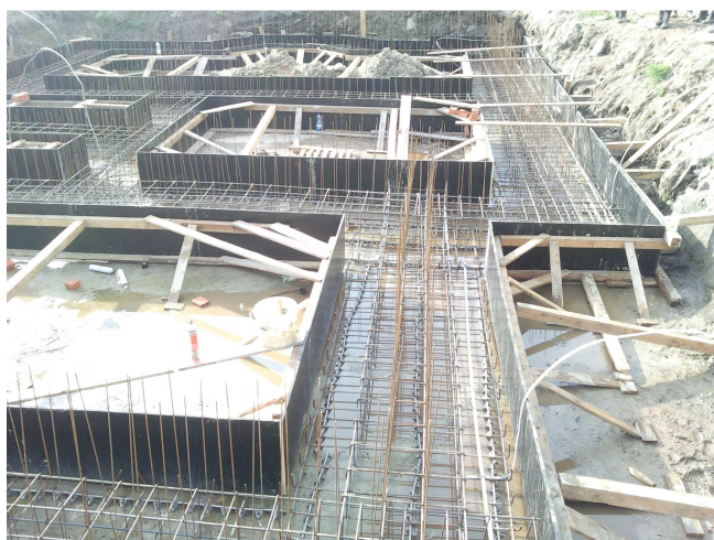
Fotografia 7. Zbrojenie ław żelbetowych
