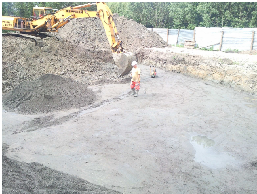
Fotografia 6. Wykop zabezpieczony 10 centymetrową warstwą chudego betonu
