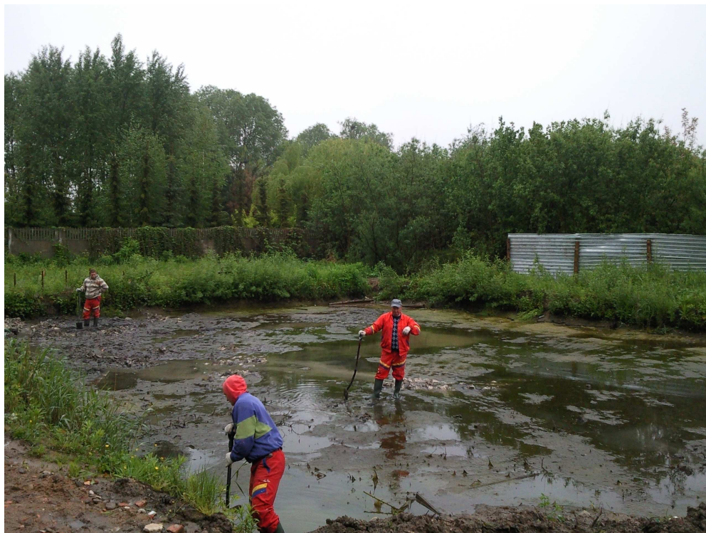
Fotografia 3. Grunt na dnie wykopu, został naturalnie uplastyczniony w wyniku kontaktu z wodą
