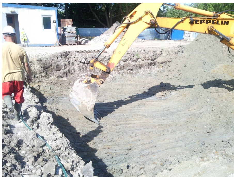
Fotografia 5. Warstwa suchych i twardych glin.
