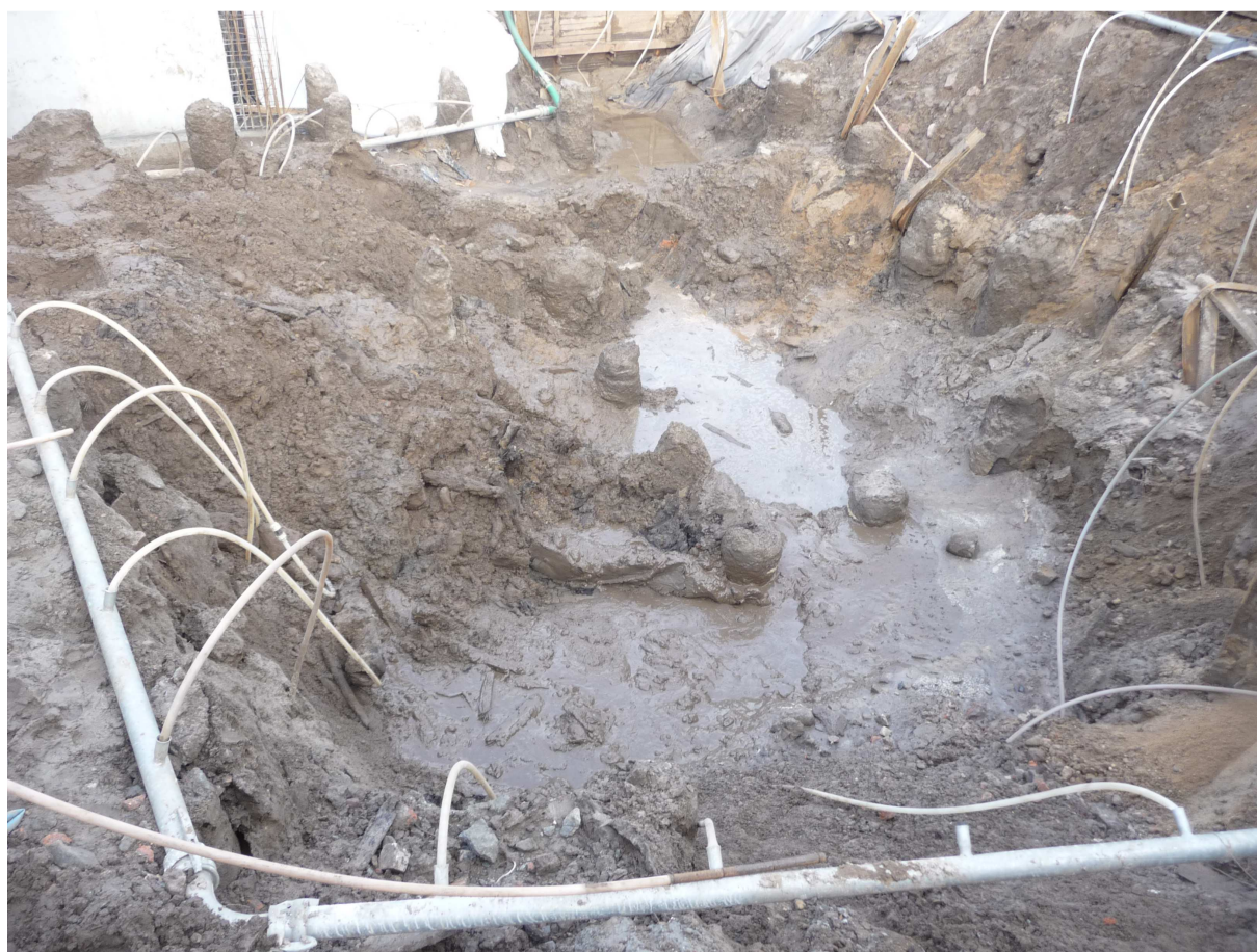
Fotografia 2. Woda powierzchniowa niezassana przez igłofiltry
