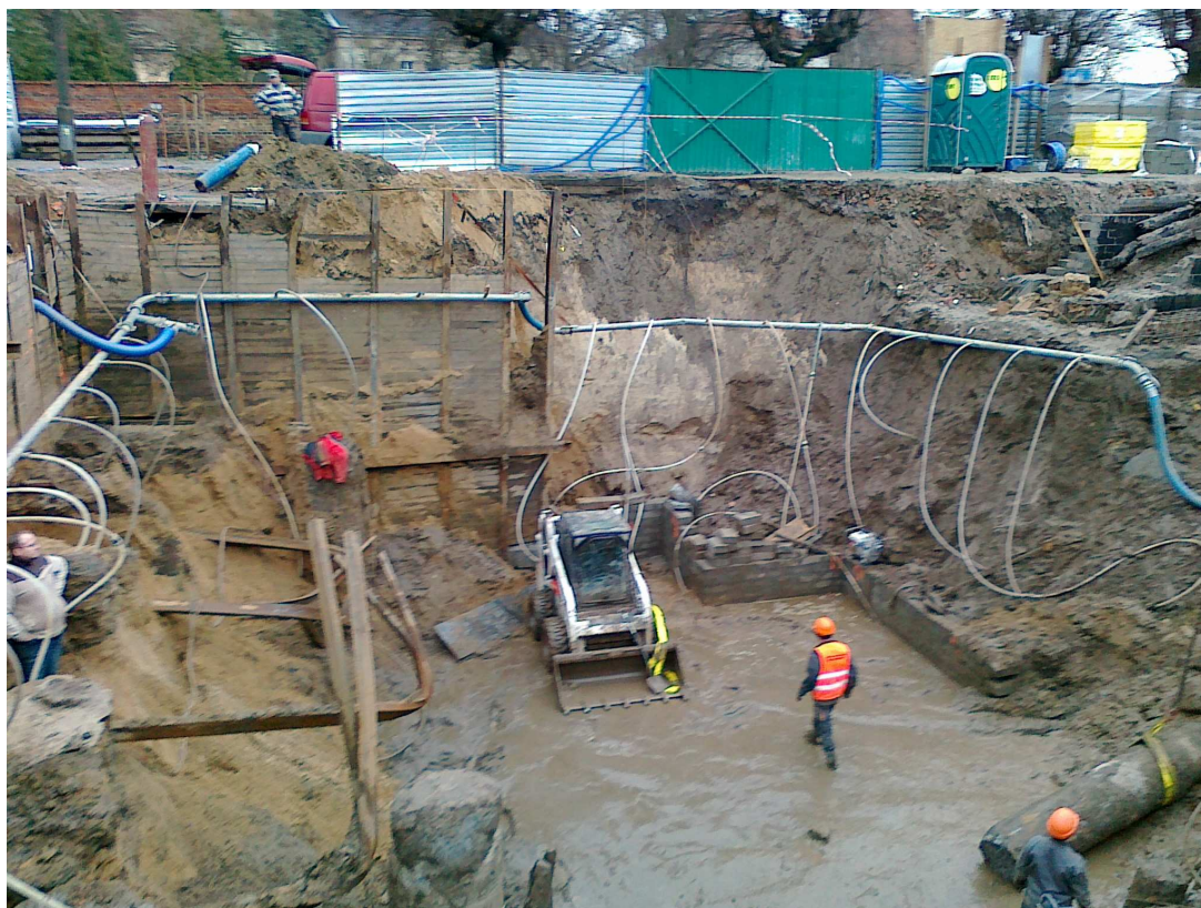
Fotografia 3. Układ igłofiltrów
