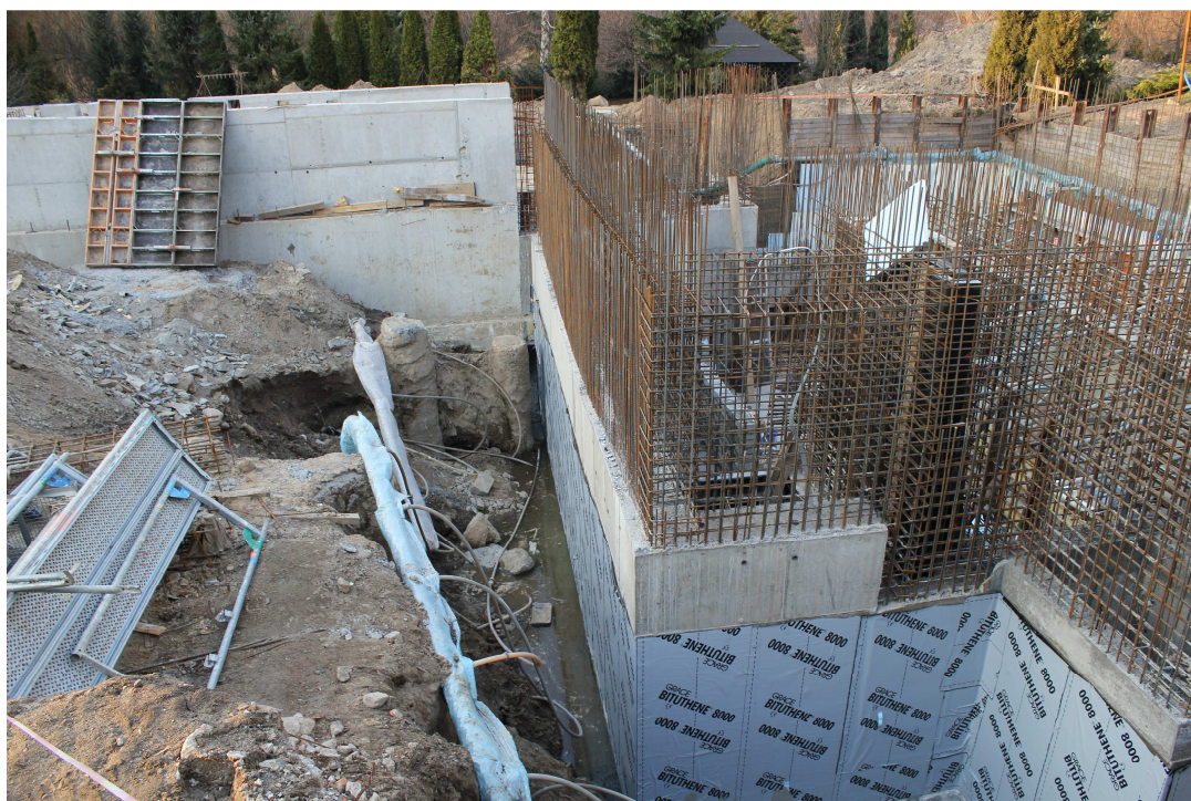
Fotografia 4. Wyłączenie igłofiltrów
