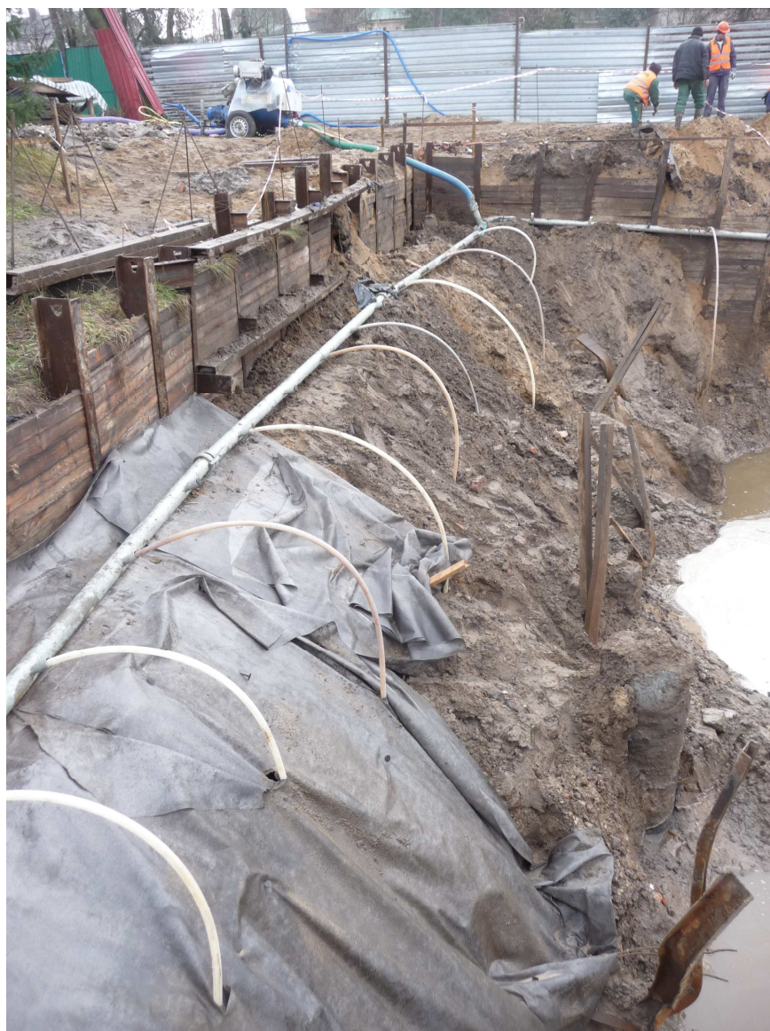
Fotografia 1. Igłofiltry oraz rury stalowe odprowadzające wodę
