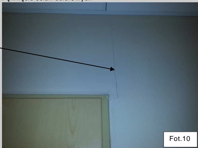
Pęknięcia ścian działowych
