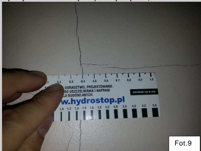
Pęknięcia ścian działowych
