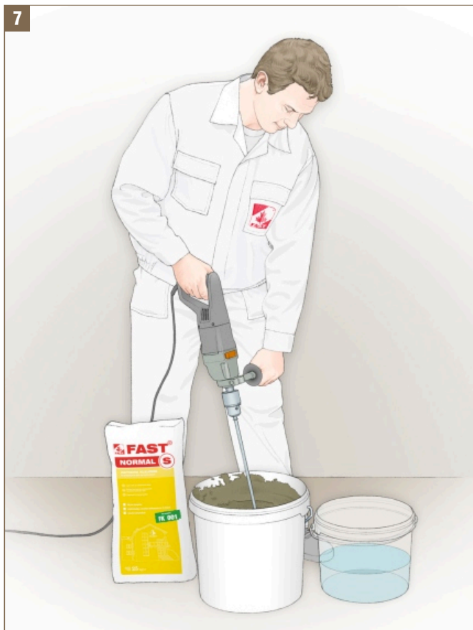
Rys. 7 - Przygotowanie zaprawy klejącej
