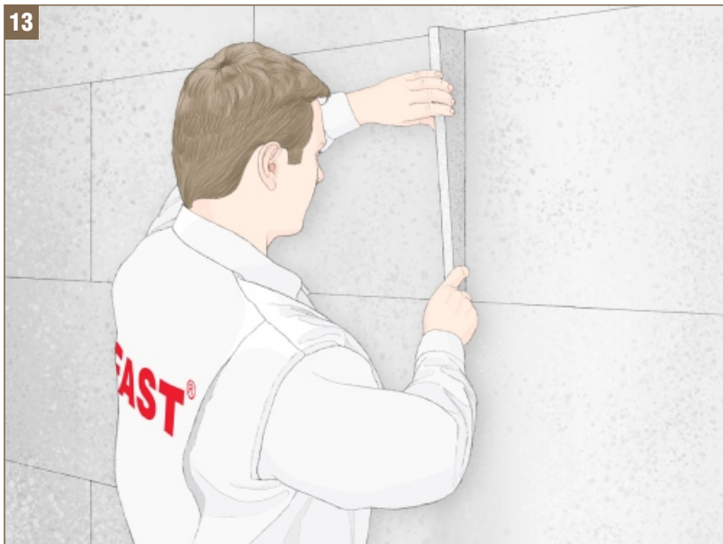
Rys. 13 - Uzupełnianie szczelin pomiędzy płytami paskami materiału termoizolacyjnego
