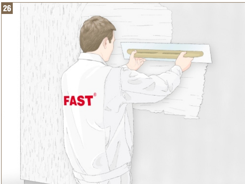
Rys. 26 - Nakładanie zaprawy tynkarskiej na zagruntowaną ścianę
