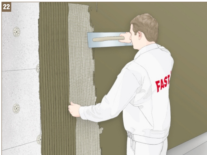
Rys. 22 - Zatopienie siatki w warstwie kleju
