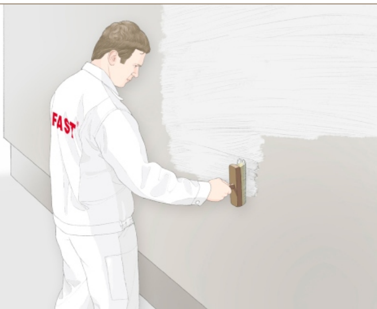
Rys. 23 - Nakładanie wyprawy gruntującej
