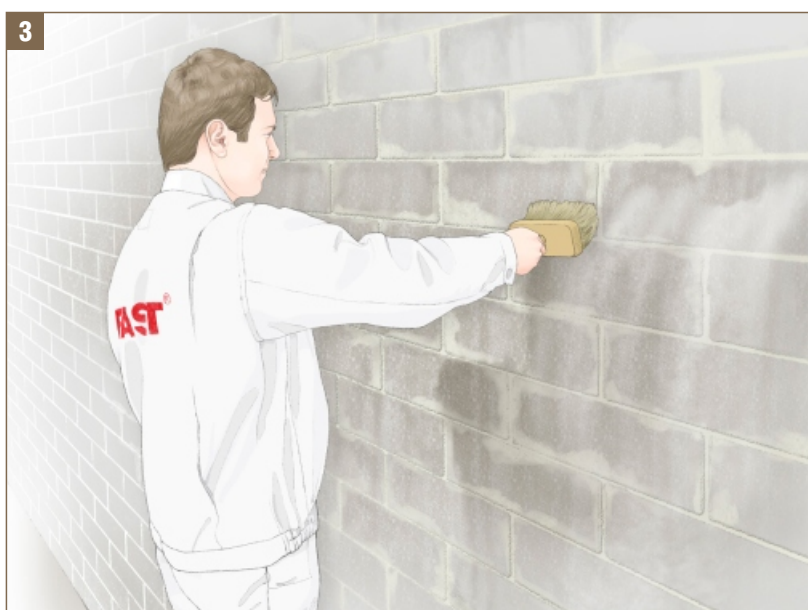
Rys. 3 - Gruntowanie chłonnych, słabych podłoży
