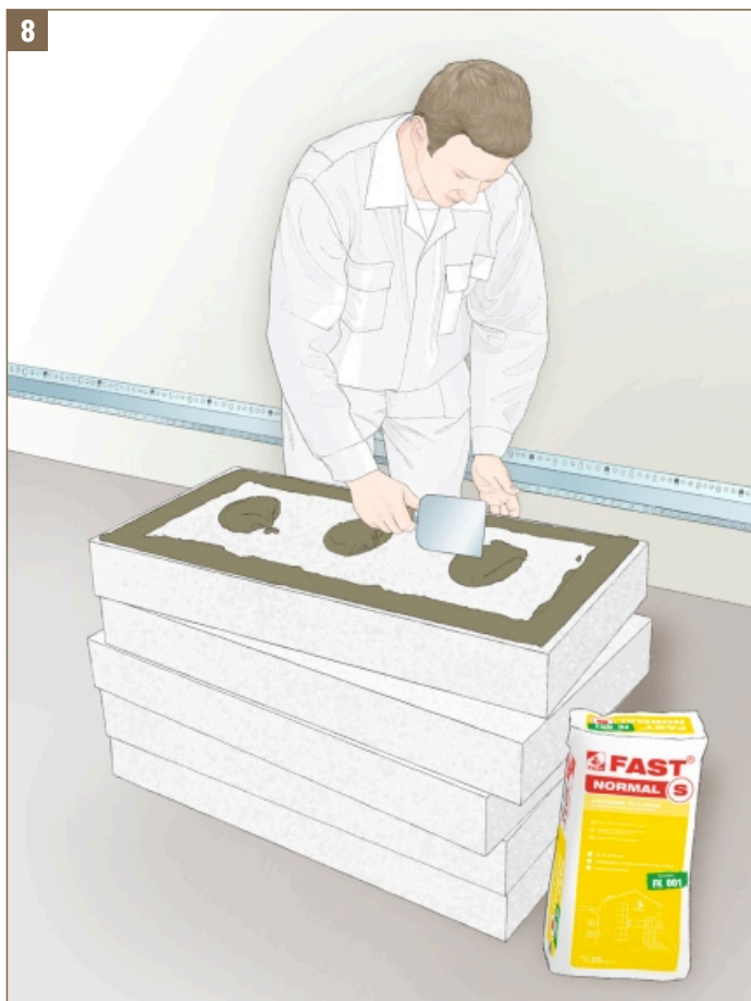
Rys. 8 - Sposób nakładania zaprawy klejowej na płyty termoizolacyjne
