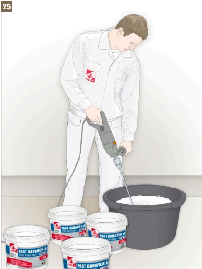
Rys. 25 - Przygotowanie mas tynkarskich przed nałożeniem (tynki akrylowe, silikatowe i siloksanowe)
