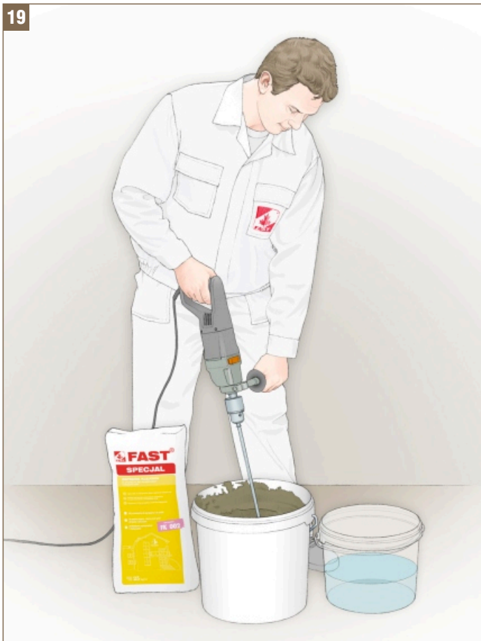
Rys. 19 - Przygotowanie zaprawy klejącej FAST SPECJAL
