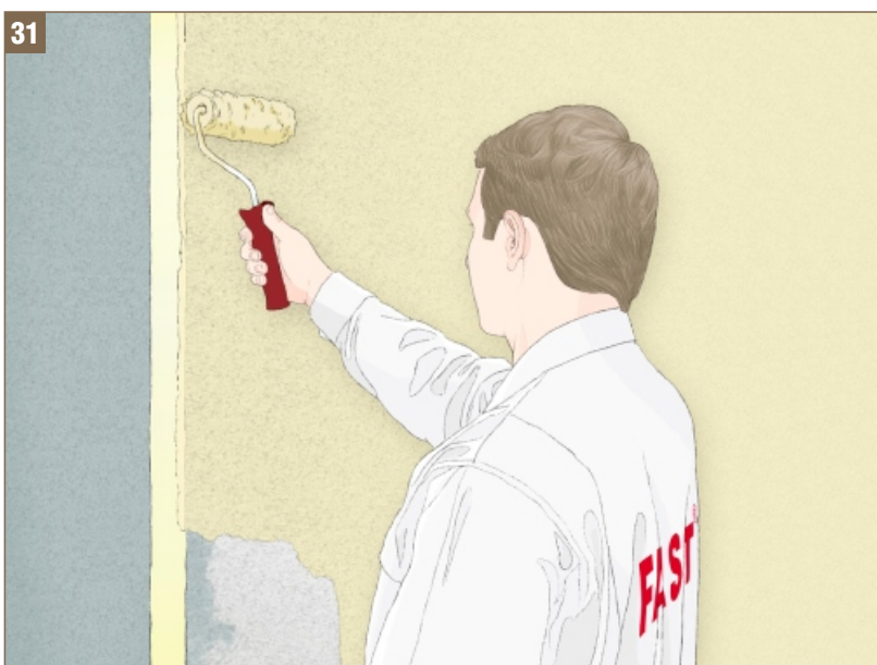
Rys. 31 - Malowanie tynków
