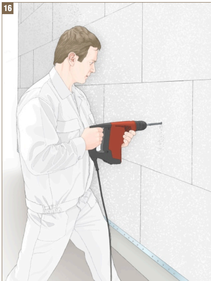
Rys. 16 - Nawiercenie otworów pod łączniki mechaniczne
