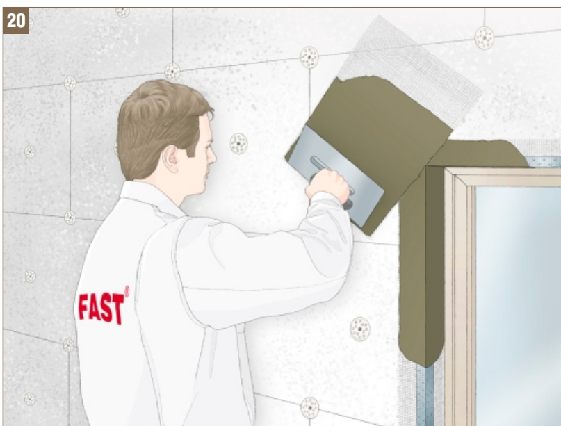
Rys. 20 - Wzmocnienie narożnika wokół otworów okiennych i drzwiowych
