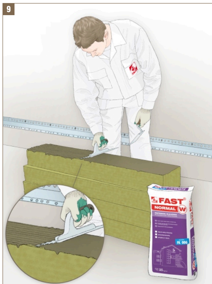
Rys. 9 - Nałożenie zaprawy klejącej na wełnę lamelową
