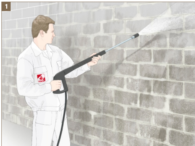
Rys. 1 - Mycie ściany pod ciśnieniem
