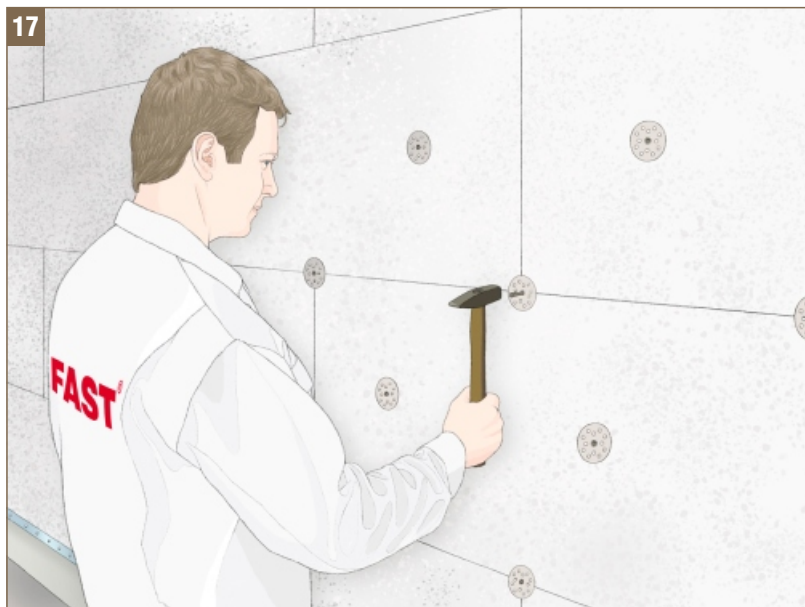
Rys. 17 - Montaż łączników mechanicznych i wbijanie trzpieni
