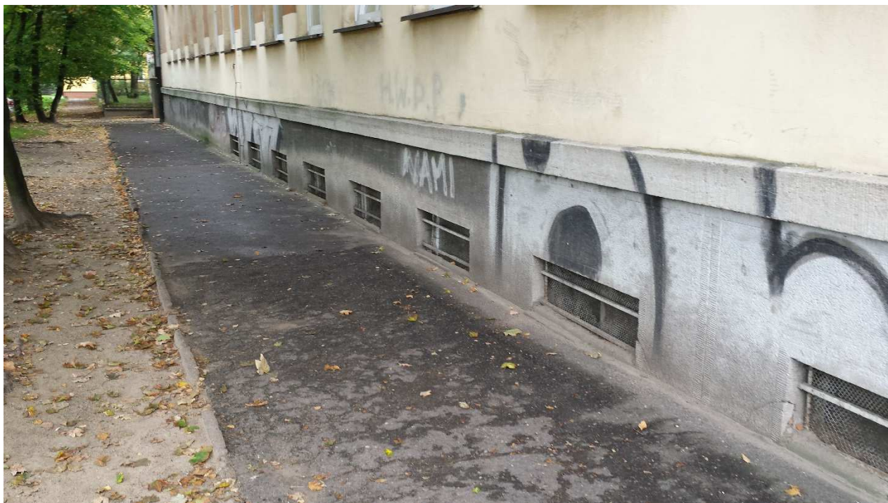
Fotografia 4. Zlikwidowane naświetla okien piwnicznych od strony ul. Przybyszewskiego
