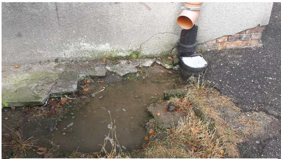
Fotografia 7. Niesprawne odprowadzenie wód opadowych do kanalizacji deszczowej oraz nieskuteczna opaska betonowa wokół budynku.
