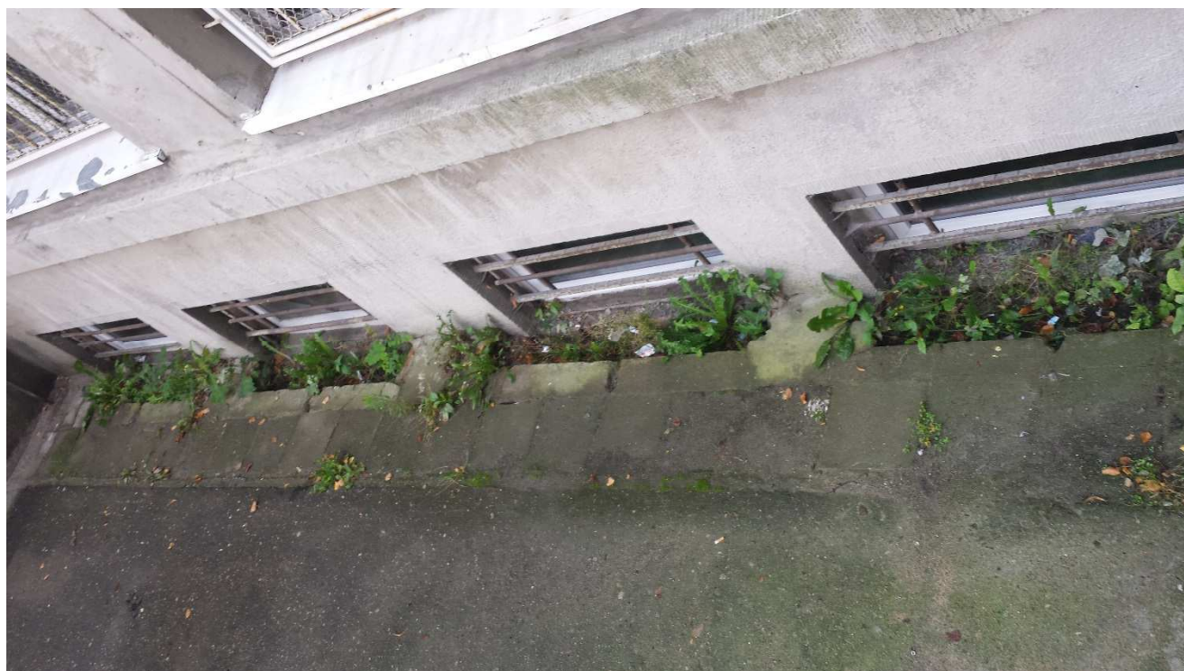
Fotografia 3. Zasypane naświetla w oknach piwnicznych.
